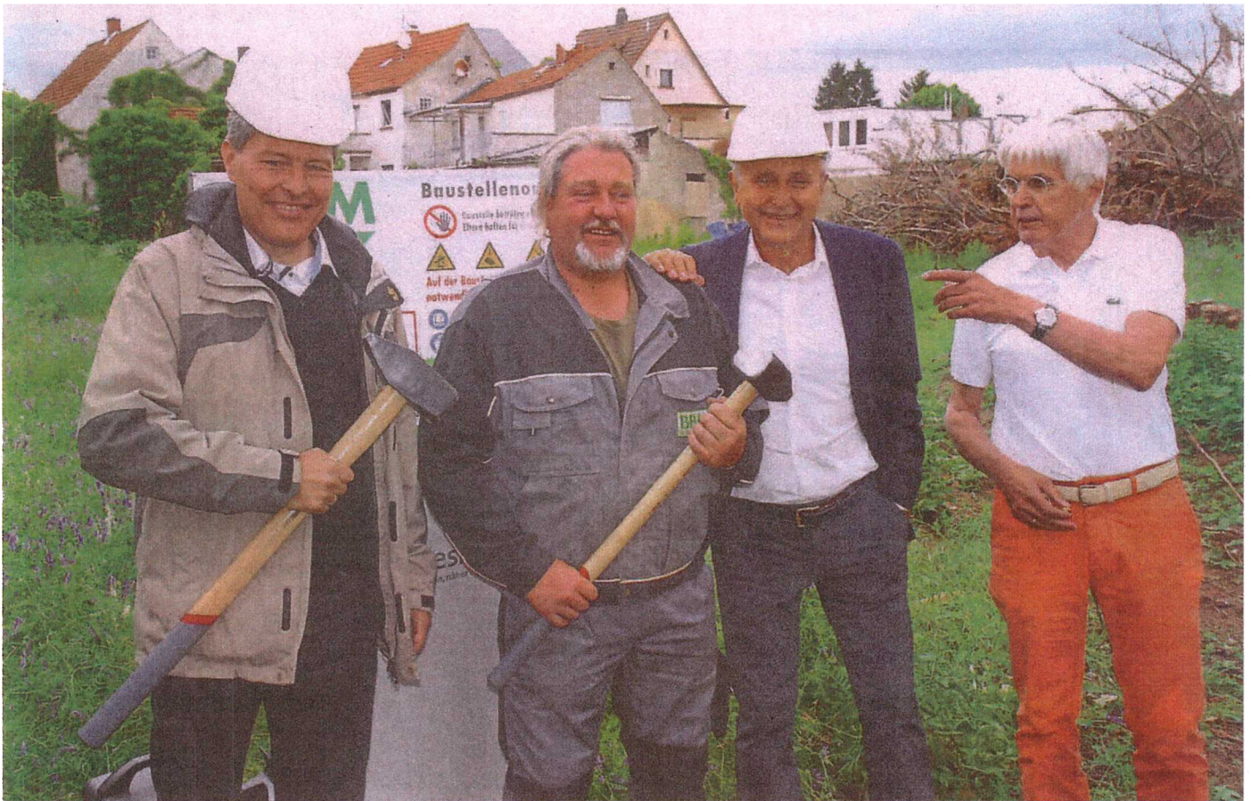
Ein Zeichen zum Start der Abrissarbeiten in der Innenstadt Griesheims setzen Bürgermeister Geza Krebs-Wetzel (von links), Kay-Erik Otte vom Abrissunternehmen BBM sowie Peter Biskupek und Ulrich Scheinert von „Biskupek Scheinert Moog“. Foto: Gudrun Hausl
